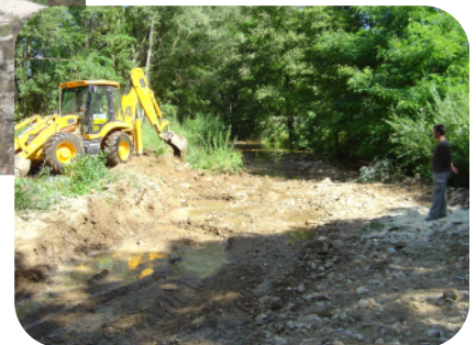
Travaux en cours d'eau
