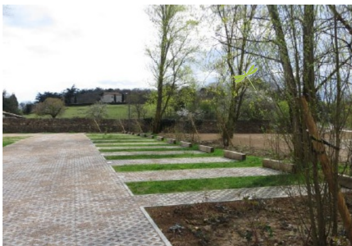
Parking végétalisé infiltrant l'eau là où elle tombe
