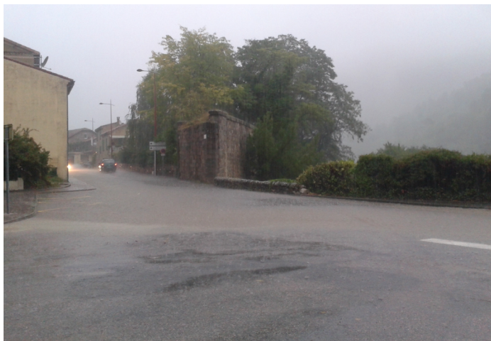
Route inondée due à une surcharge du réseau d'eau pluvial
