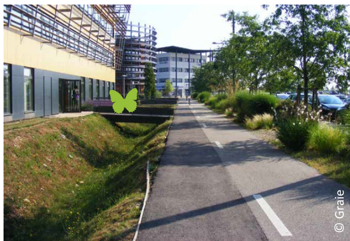
Noue ou fossé herbeux récupérant les eaux pluviales et bandes végétales entre les voies de circulation
