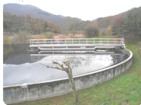
Station d'épuration de type "boues activées"
