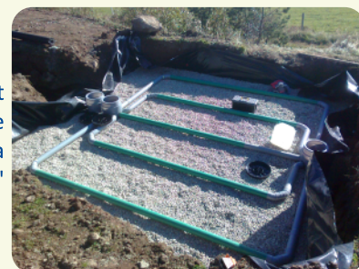
Assainissement autonome de type "filtre à sable drainé"
